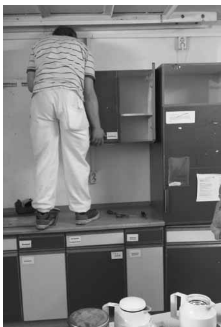
Ein Klient beim Küchenabbau
